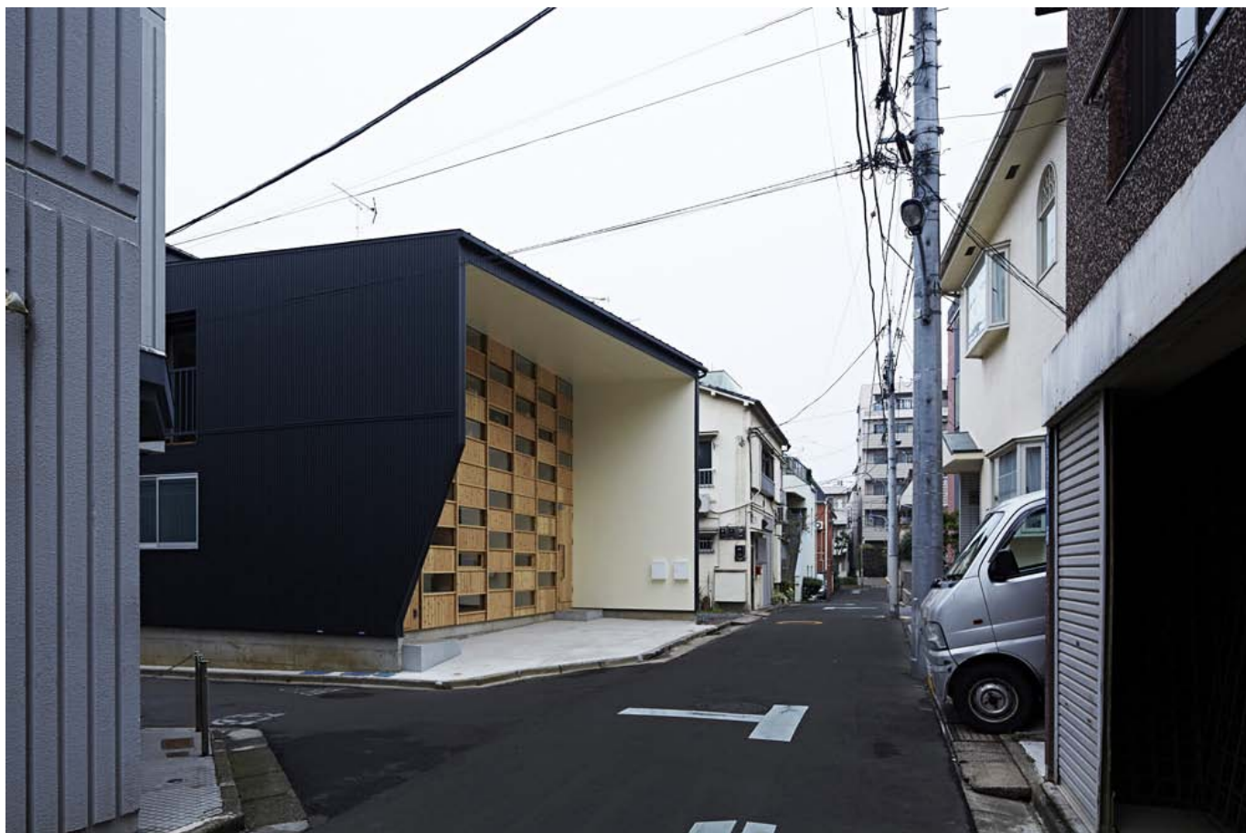
道路から建物外観を見る。外壁は国産の杉材を市松模様に貼付け、ペアガラスを設置。断熱に配慮しています。玄関ドアも外壁に合わせて杉材を利用しています。
