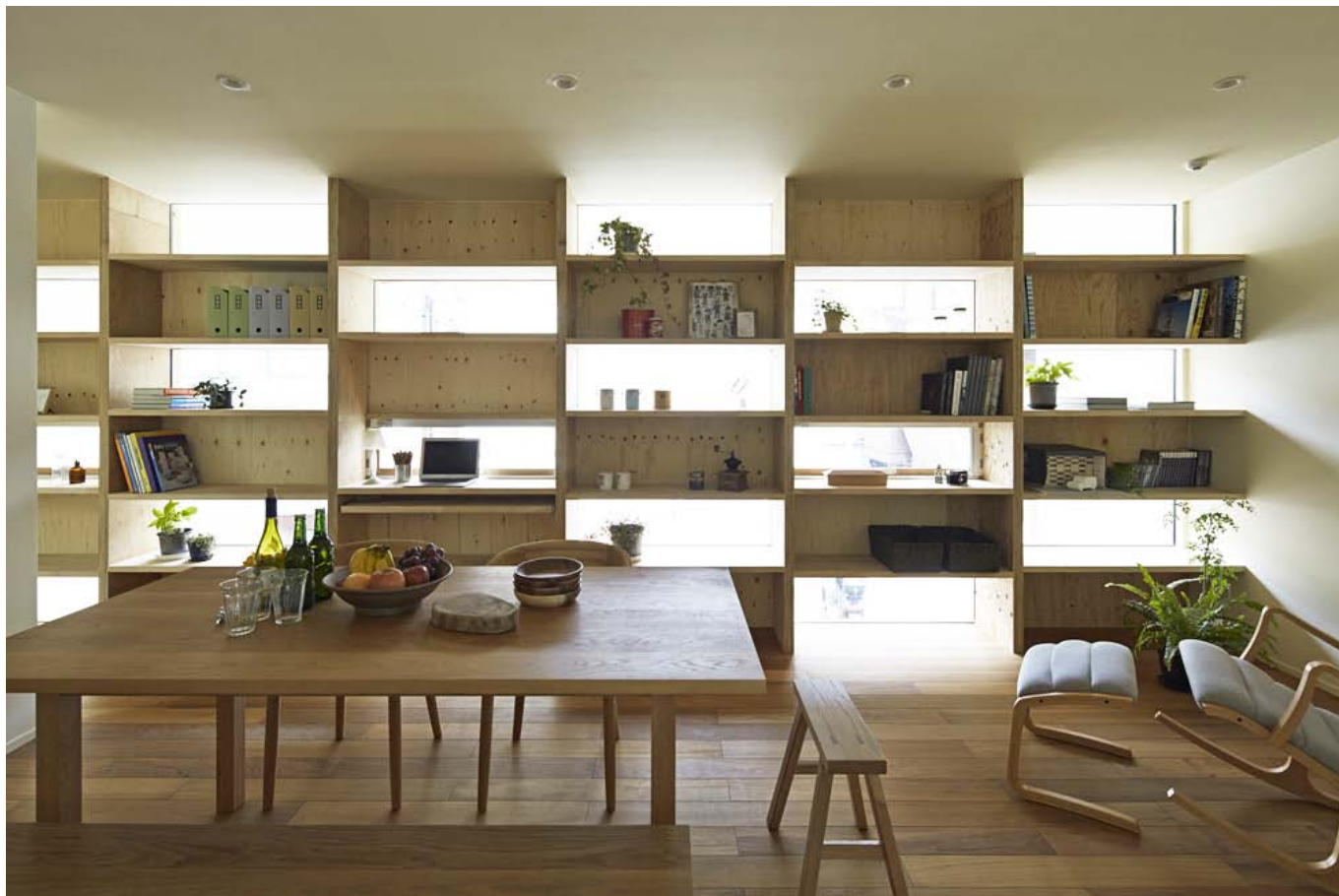
窓でありディスプレイの棚である市松模様の壁面。様々な趣味の物を飾りつつ北側からの視線を防ぐ。50%が窓であるが棚に奥行きがあるので、外部からの視線はほとんど気にならない。
