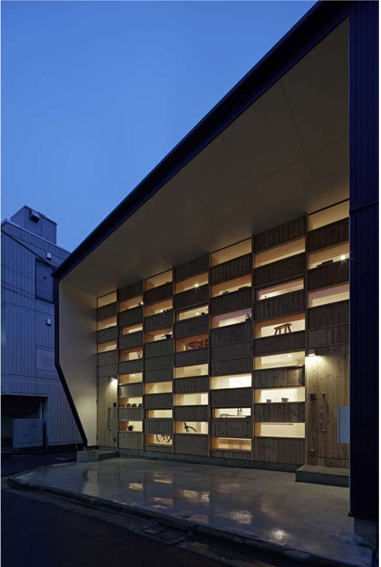
道路から見た建物の夜景写真。市松模様のガラス面から洩れる光によって建物全体が照明器具のような印象となっています。ガラス部分は5カ所が開閉可能です。
