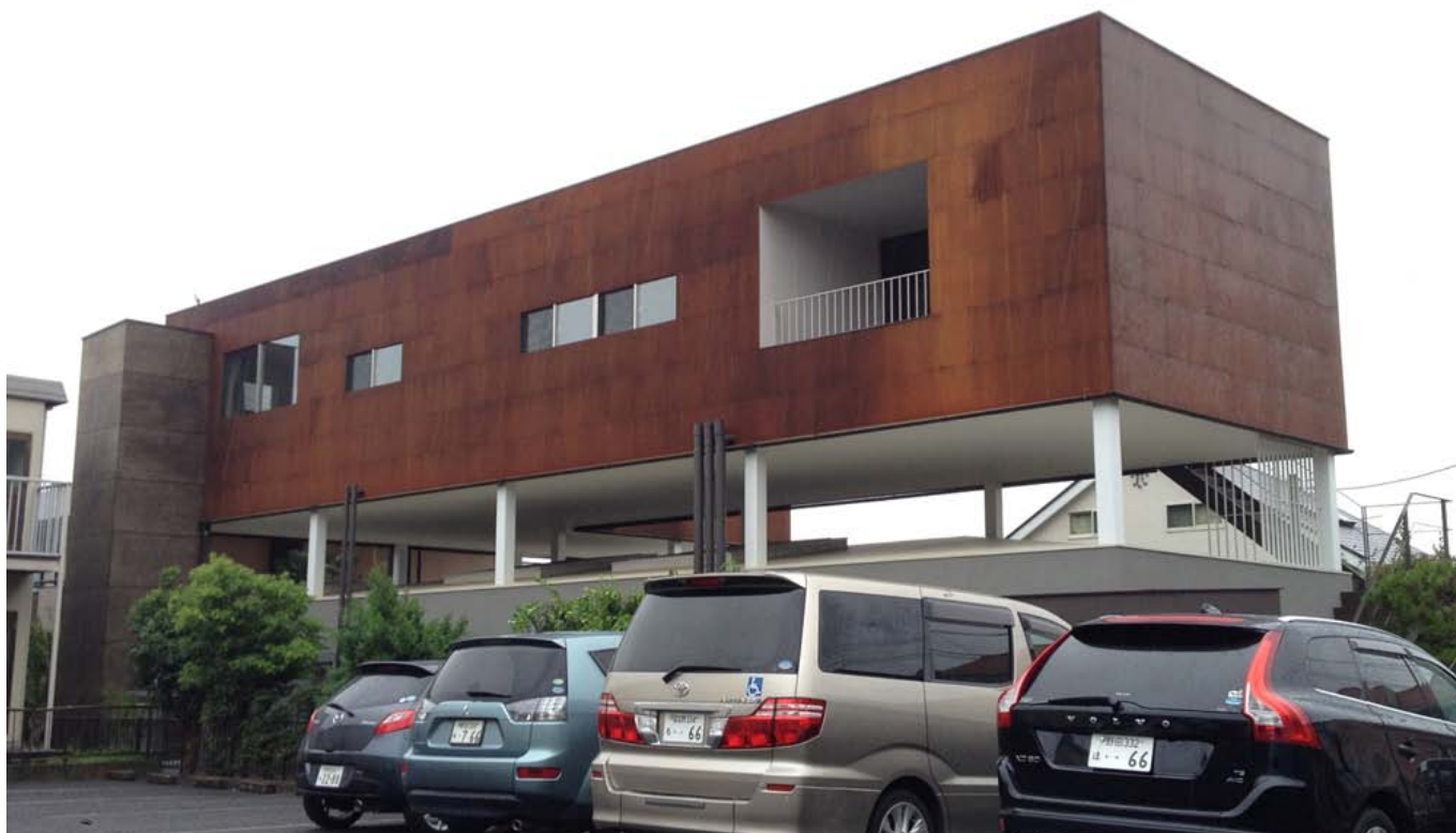
南東側から見た外観。施主要望で2階の外壁仕上げをコルテン鋼としています。 コルテン鋼の目地割りや窓まわりの納まりに気を配ることにより、無駄がなくシャープな印象となります。
